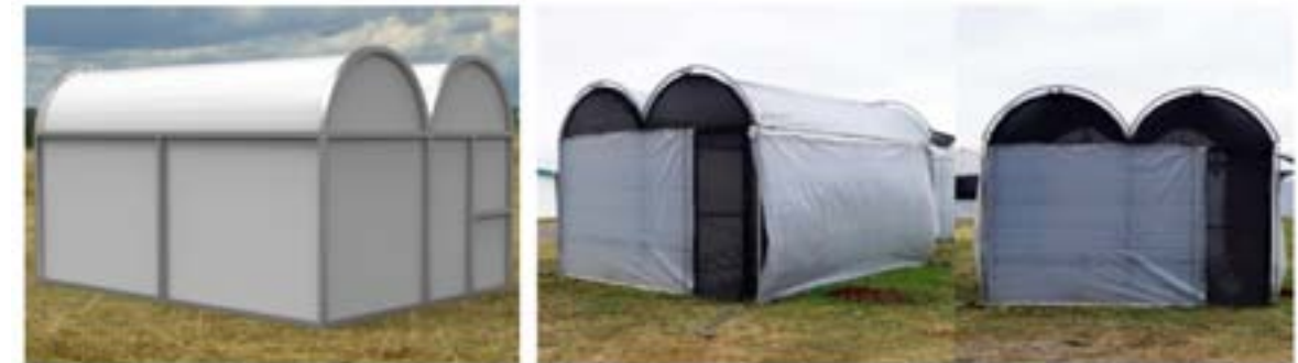
Figura 7. Modelado y construcción del prototipo de invernadero híbrido
