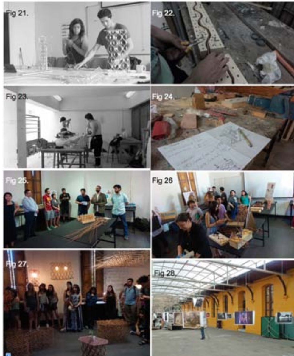
Fig. 22: Imagen de trabajo de construcción de máquinas finales.
