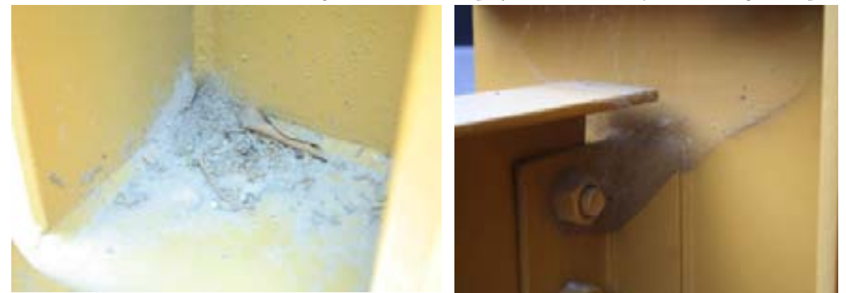
Figura 5. Suciedad superficial acumulada y residuos orgánicos pro-
