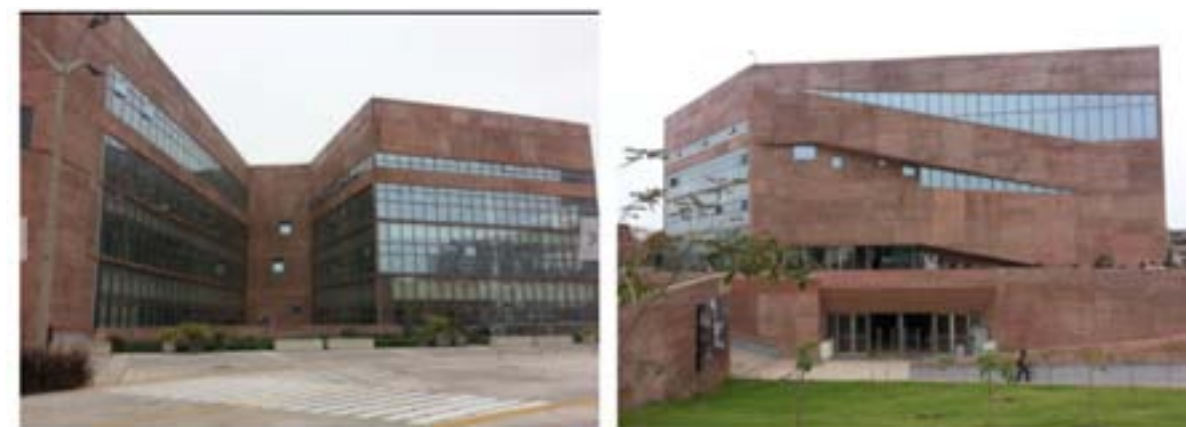
Fig. 1. Fotografías del Edificio de la Biblioteca de la PUCP, con certificación LEED.
