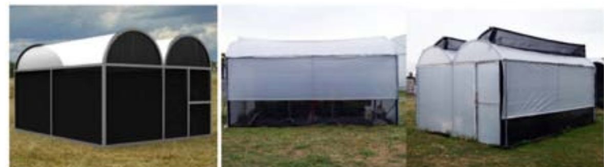
Figura 8. Modelado y construcción del invernadero control con ventanas con cenitales abiertas
